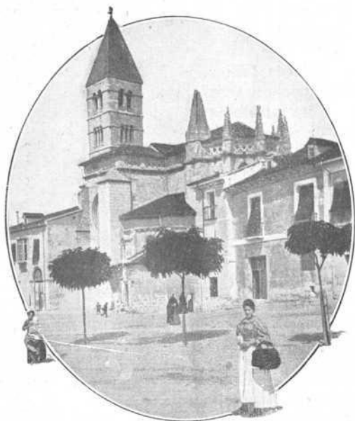
La Antigua (por la calle de Cabañuelas).
