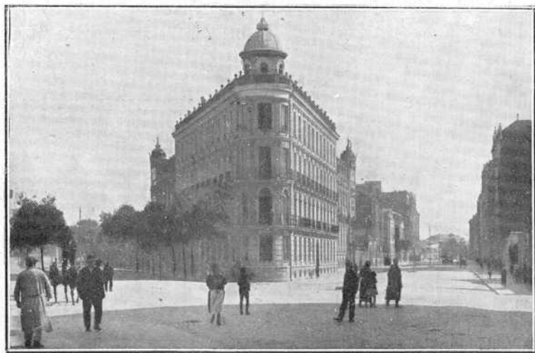
Calles de Muro y Gamazo.
