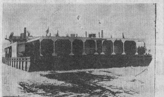
Central eléctrica flotante sido botada al agua una central eléctrica flotante destinada a Venezuela. La estación generadora diesel, de 156 pies de largo por 80 de ancho, será instalada en el lago Maracaibo, de la nación sudamericana.—(Foto Gil del Espinar)
