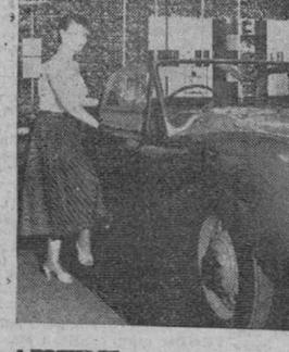
En Londres se ha exhibido este nuevo modelo de coche Martín, cuya carrocería ha sido moldeada de una pieza, en plástico compuesto de resina de poliestireno y fibra de vidrio. Este material aguanta violentos impactos, no se abolla y puede ser reparado fácilmente.—(Foto Gil del Espinar)
