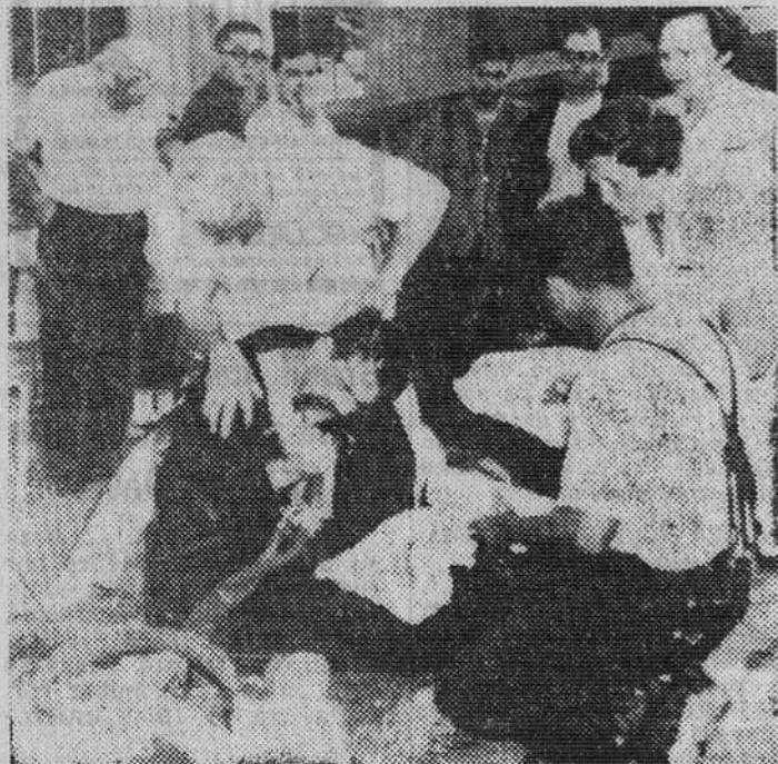
Se hacen cada vez más necesarios los «corredores de escape» en caso de incendio. Son muchos más los muertos por asfixia que los originados por quemaduras. Los «corredores de escape» evitan las primeras. El joven de la fotografía está recibiendo los primeros auxilios. Nótese como aspira oxígeno. (Foto CIFRA)
