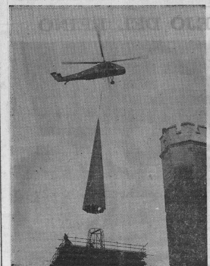
Un gran helicóptero «Wessex» birreactor de la RAF coloca una cúpula de fibra de vidrio de dos toneladas de peso sobre su base en la torre de la capilla del Colegio de Administración de Ashridge, en Inglaterra. La aguja mide 17 metros de altura y tres de diámetro, y está construida en resina de vidrio, siendo capaz de soportar vientos hasta de 190 kilómetros por hora. — (Foto FIEL)
