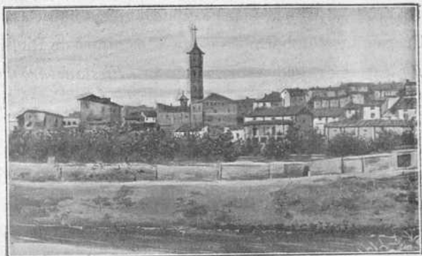
FIG. 34.—Vista de Ricla desde el camino de la estación.
