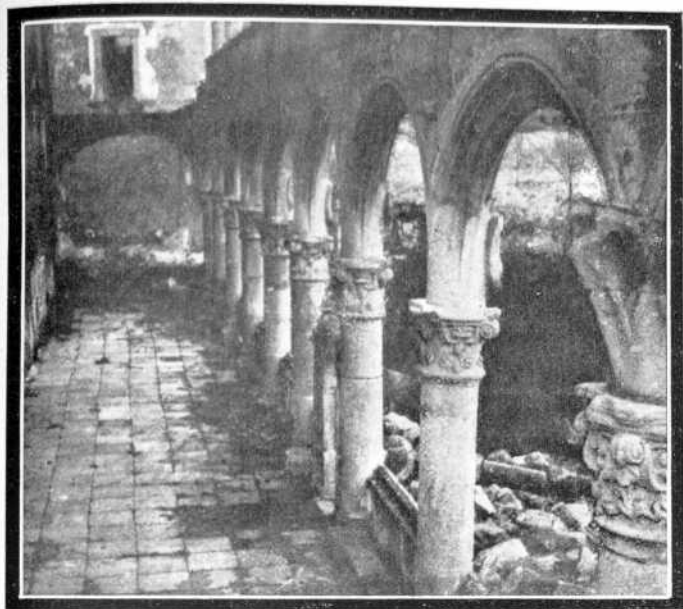
RUINAS DEL ANTIGUO CLAUSTRO DEL MONASTERIO DE YUSTE
