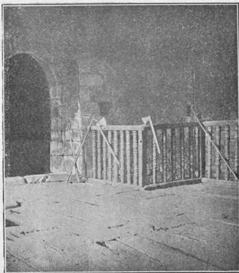
Interior del piso alto de la torre de Bracho en Ruiseñada.
