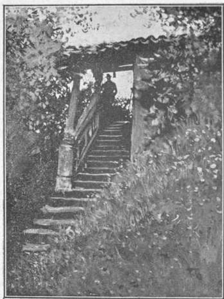
Escalinata ruínosa de la casa solariega de Fernández de la Vega, en Ruiseñada.
