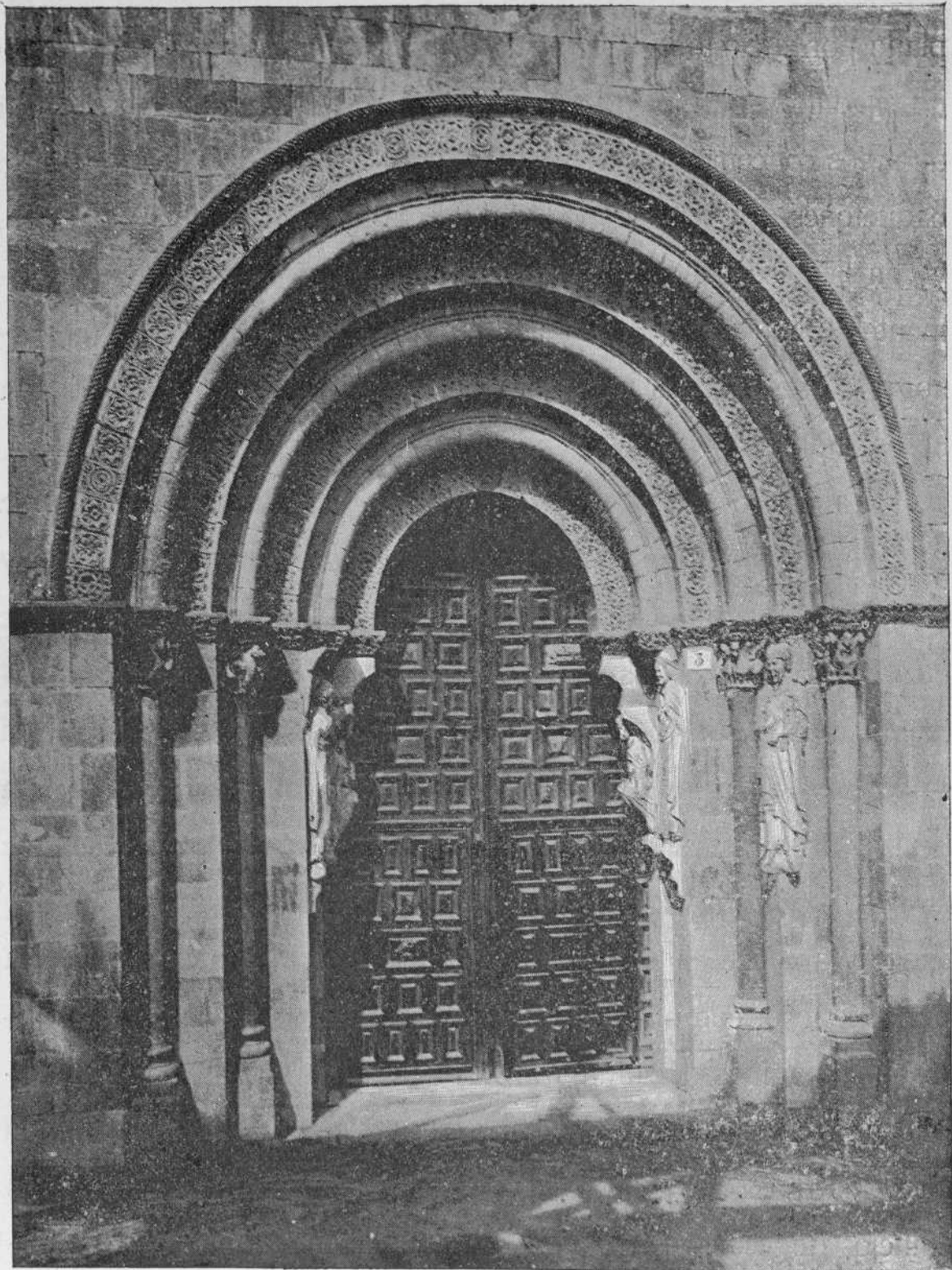
PORTADA EN LA FACHADA SUR
