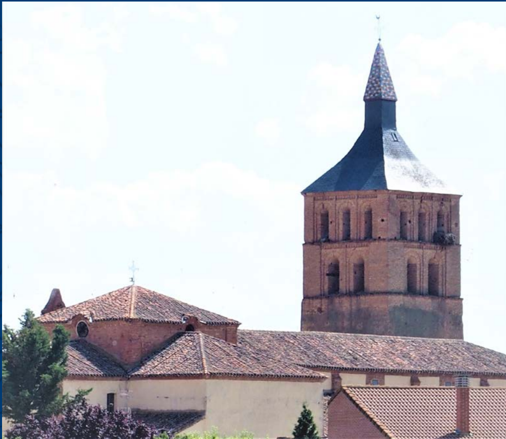
Vista parcial de la iglesia de San Pedro Apóstol en Villademor de la Vega. León
