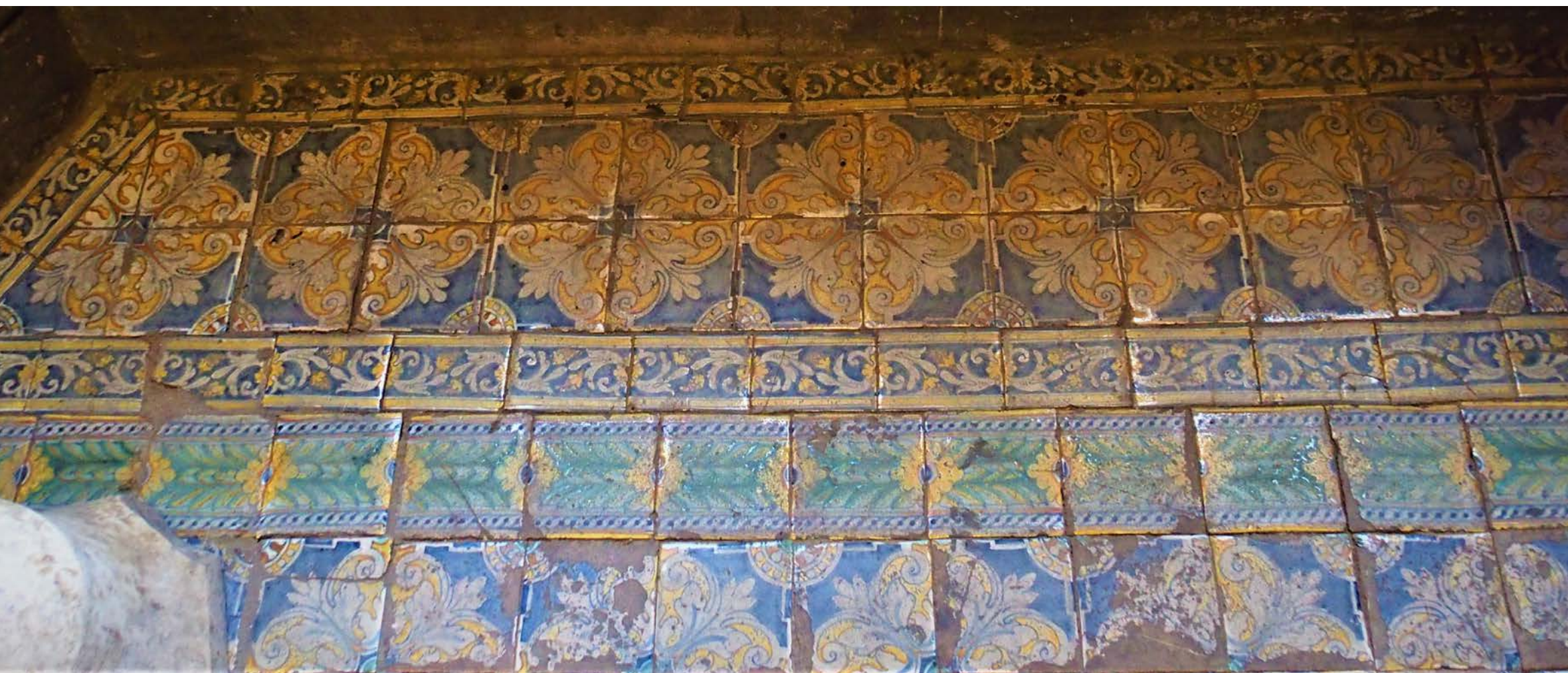
Detalle de la greca y cintas colocadas en la base del gran ventanal del camarín
