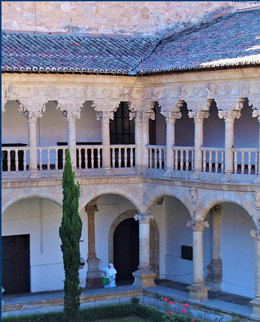
Vista parcial del claustro del convento de Santa María de las Dueñas, Salamanca
