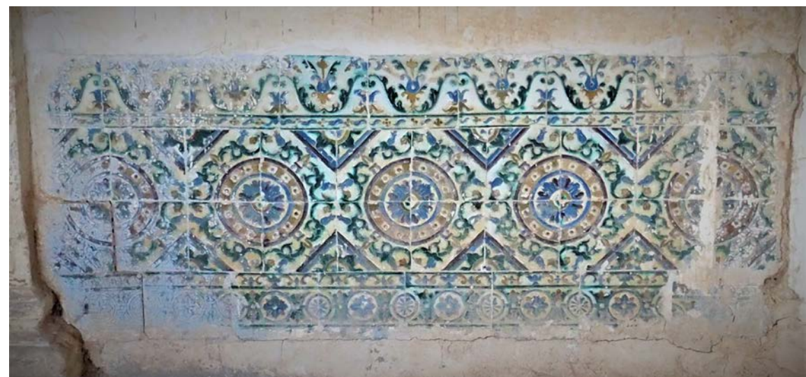
Detalle del arrimadero de azulejos de arista del salón de la planta superior
