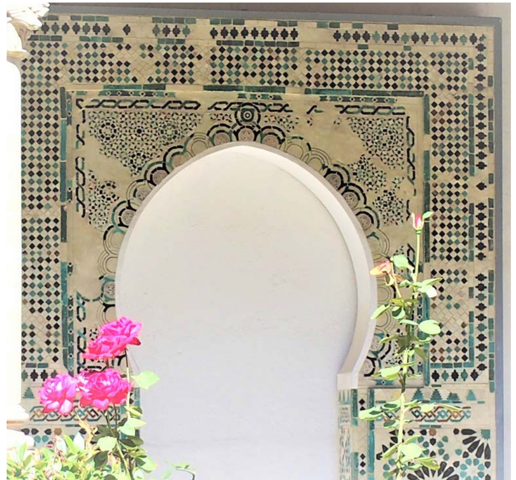
Detalle del arco con alicatados colocado en el claustro bajo del convento de Santa María de las Dueñas de Salamanca
