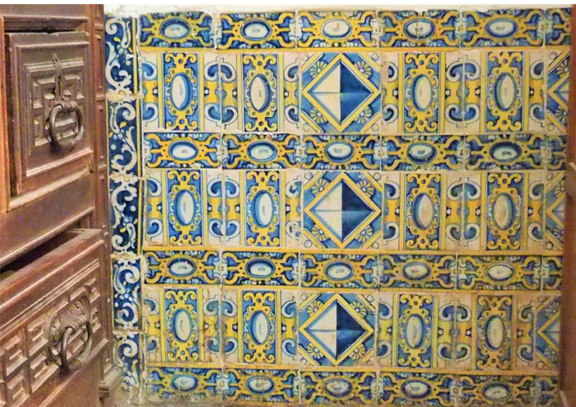
Detalle del arrimadero de azulejos junto a la cajonería de la sacristía
