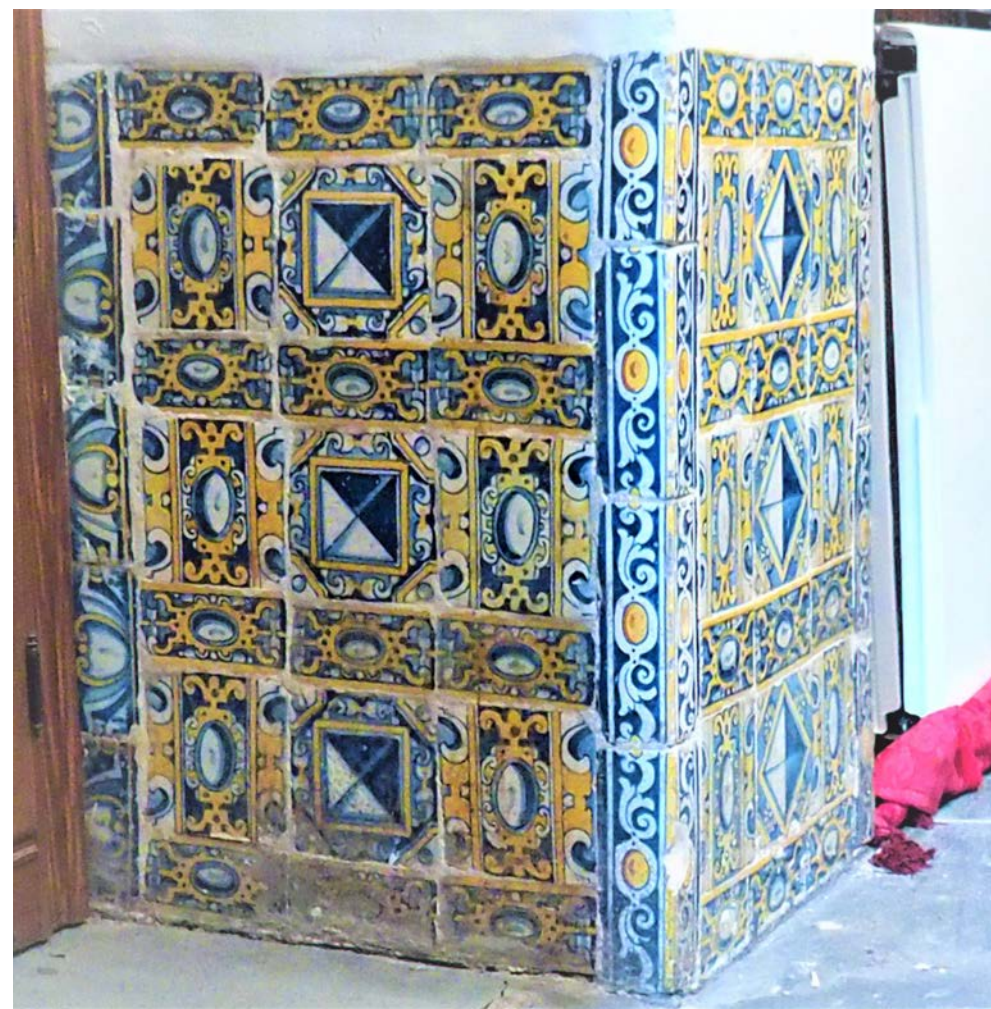
Detalle del arrimadero con todas las labores de azulejería de la sacristía
