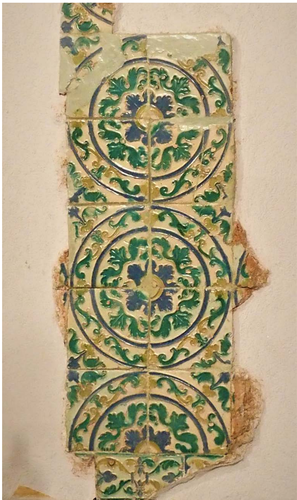
Panel de azulejos de arista colocado en el muro del presbiterio junto al retablo
