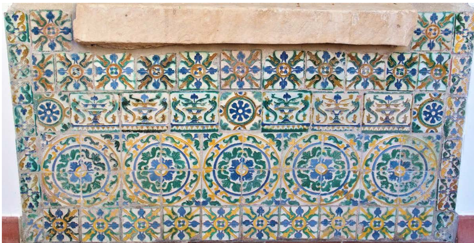
Vista del primer zócalo bajo ventana de la panda sur del claustro bajo
