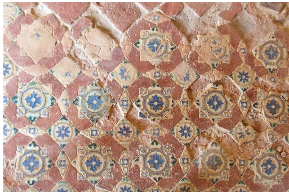
Detalle del pavimento de la habitación de la planta baja junto a la loggia
