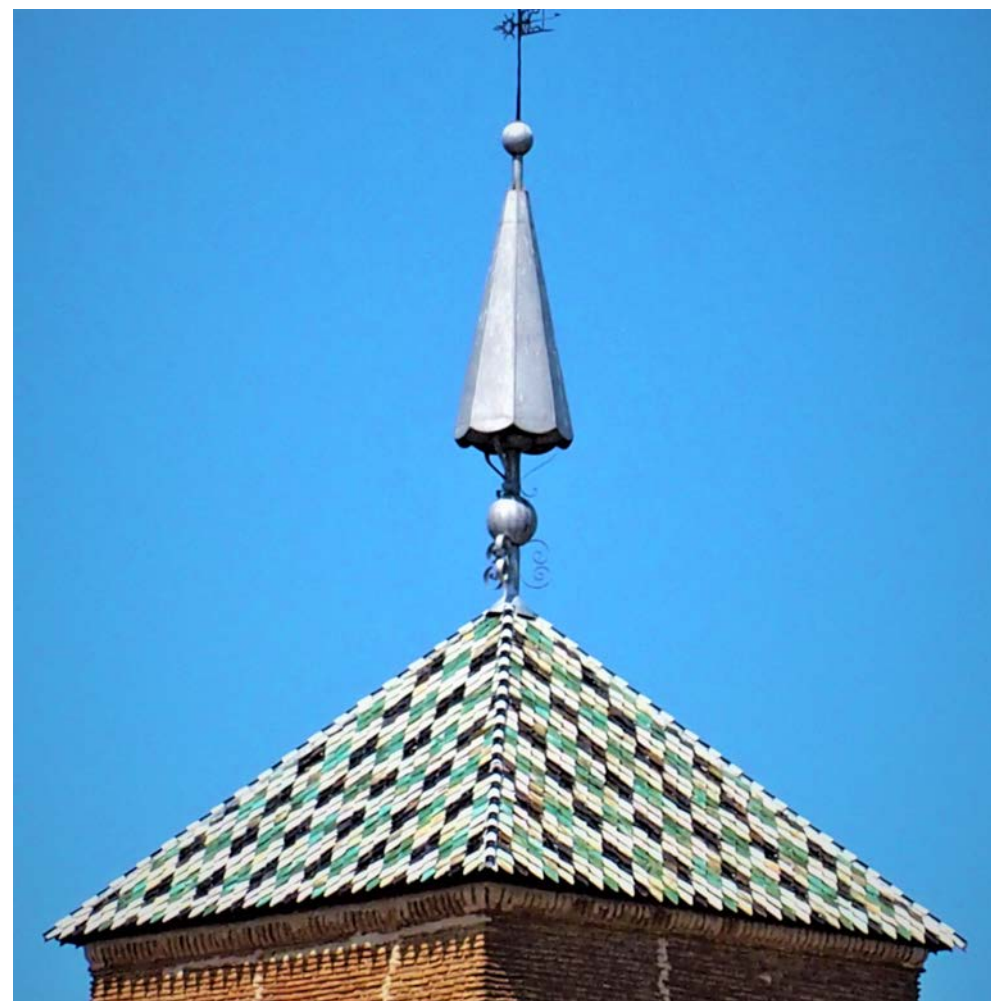
Detalle del tejado de la torre campanario
