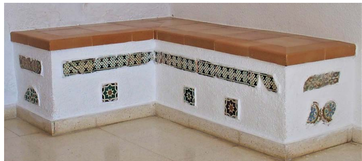
Azulejos de arista colocados en el banco corrido junto a los baños del colegio
