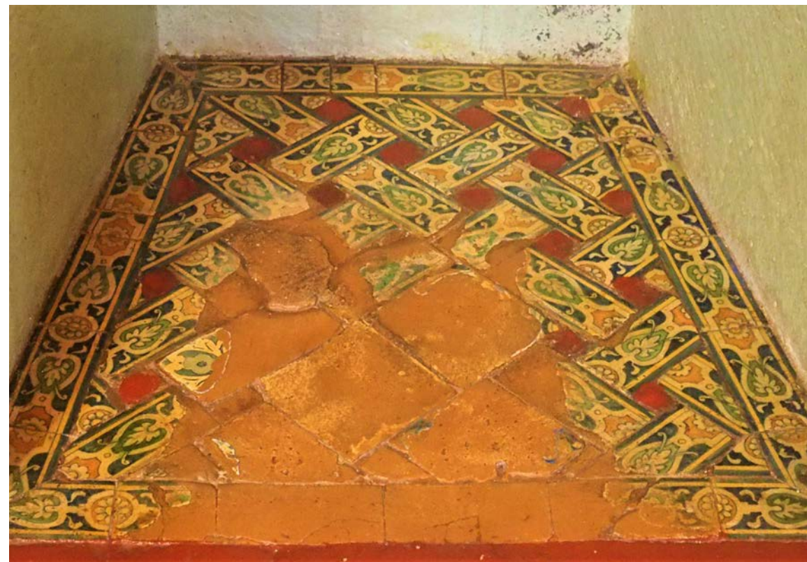
Vista de las cintas colocadas en el pavimento del “torno de comunión”
