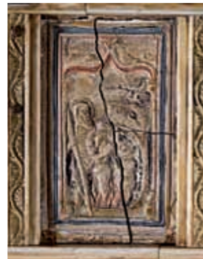
Detalle de estado inicial
