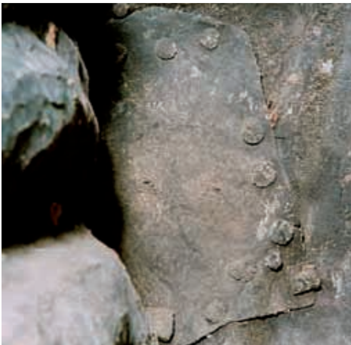
Detalle de procesos de corrosión
