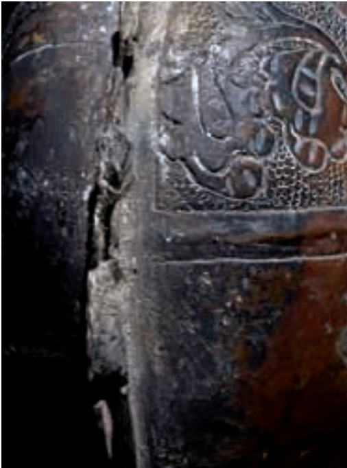
Detalle de intervención de reparación anterior con soldadura en bronce
