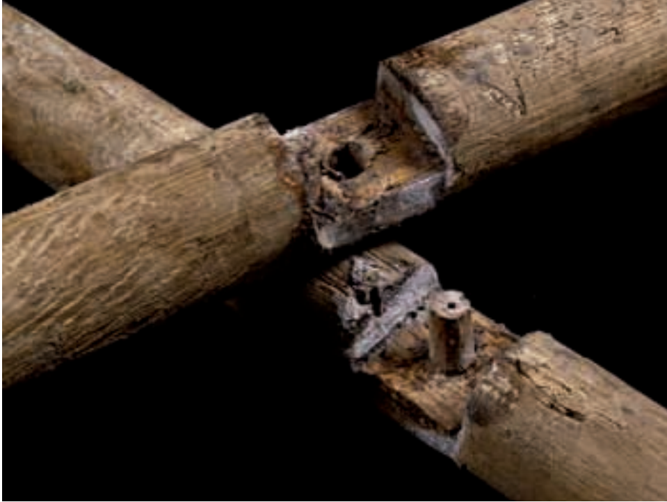
Detalle del anclaje del alma de madera
