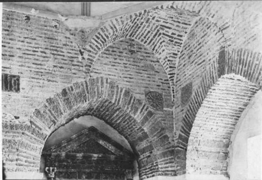
Sacristia del Real Monasterio de Sta Clara de Tordesillas.
