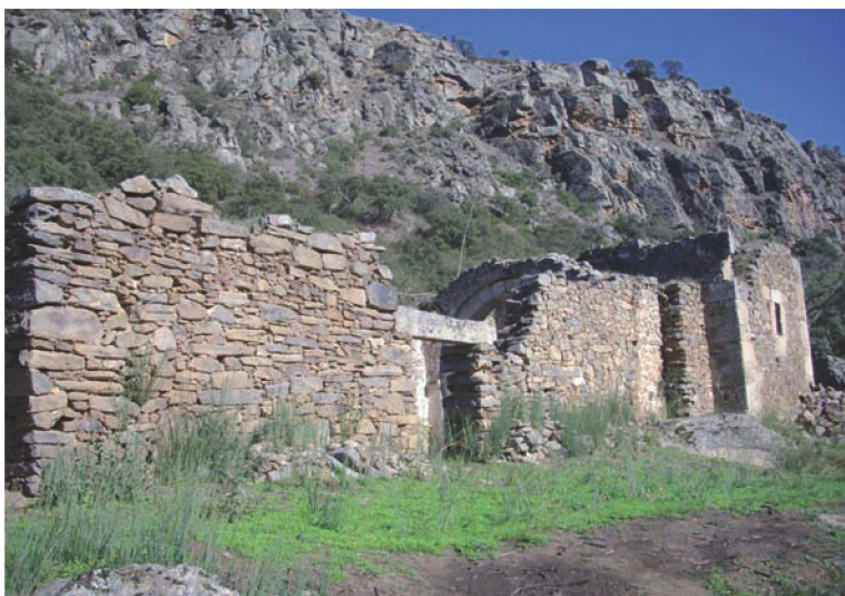
Fig. 57. Ruinas de la ermita de San Esteban
