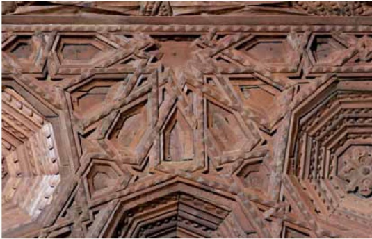
▲ VILLAMAYOR DE CAMPOS. SAN ESTEBAN. Armadura del presbiterio. Detalle de la lacería, rodeada por una serie de casetones.
