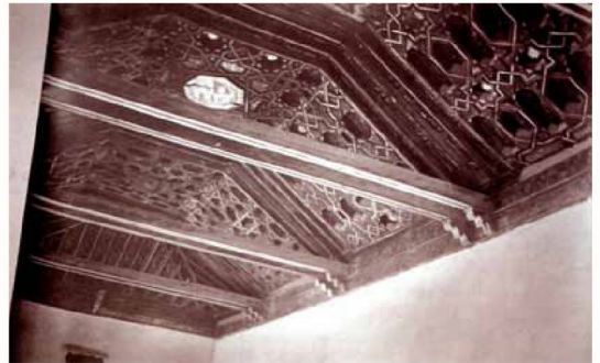
▲ TORO. PALACIO DE LAS LEYES. Armadura del salón principal del palacio destruída
