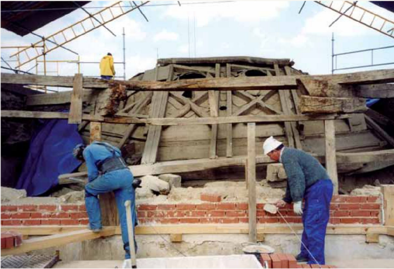
◀ VILLAMAYOR DE CAMPOS. Iglesia de San Esteban. Trabajos de restauración de la armadura de la capilla mayor (gentileza de REARASA)
