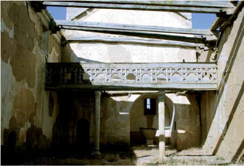
◀ PINILLA DE TORO. Iglesia de San Esteban. Estado actual. Restos del coro y de la armadura que cubría la nave del templo.
