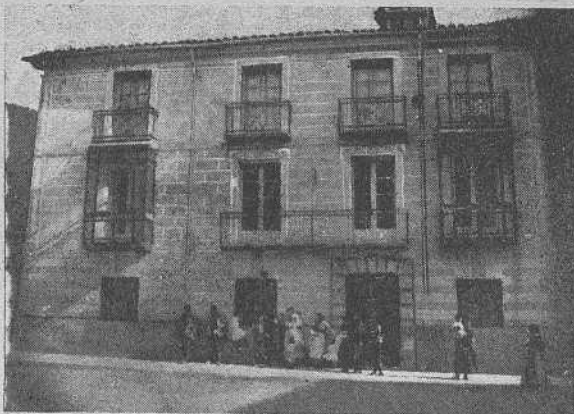
Casa del Sr. Arias de Miranda en Aranda de Duero.
