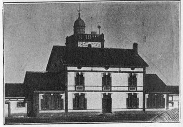
Granja Agrícola: Pabellón de oficinas, laboratorio, observatorio y clases.
