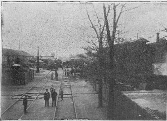
Talleres del Norte: Entrada principal de los talleres.
