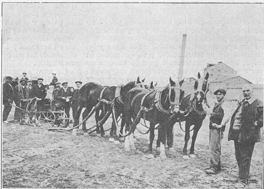
«La Rasa»: Moderna maquinaria en trabajo.
